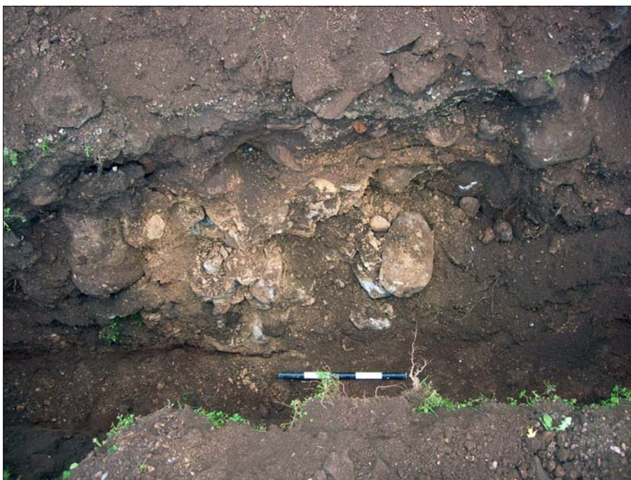
Figur 8. Genombrottet i kyrkogårdsmurens nordöstra del. Kring en äldre kärna med stenar i kalkbruk hade ytterligare stenar placerats och avsevärt ökat murens bredd. Foto mot V Christer Carlsson, ÖLM.
