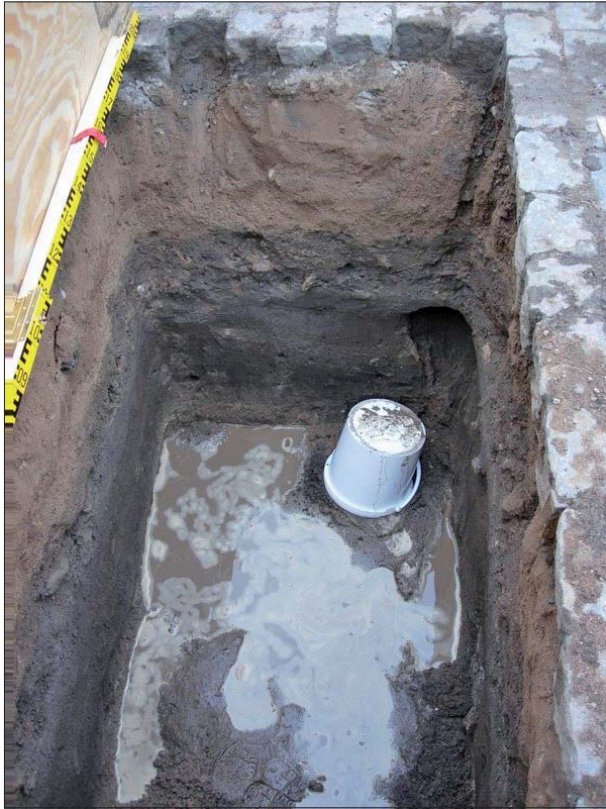
Figur 6. Schakt 2 mot öst. Foto Ingrid Gustin, ÖLM.
