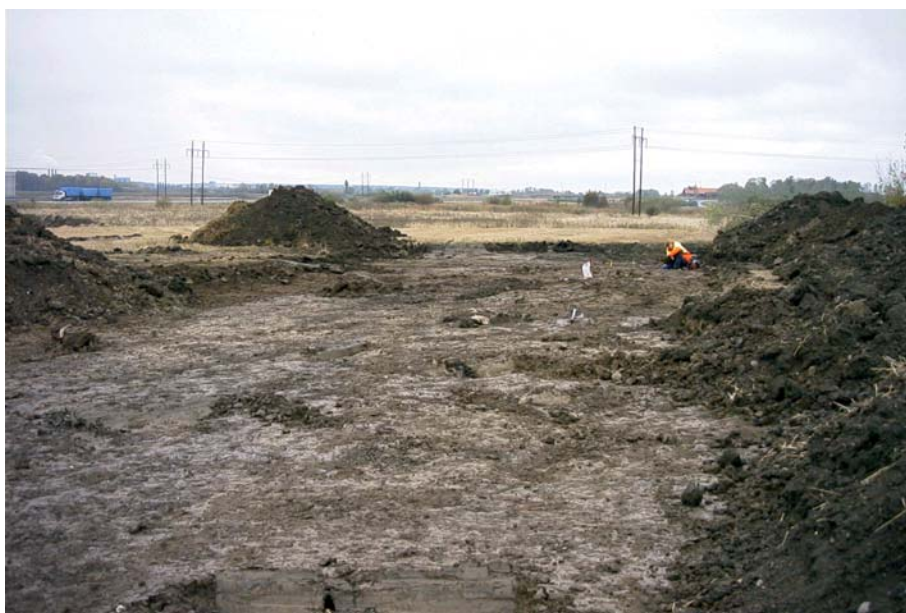
Figur 5. Översikt över det schaktade området med E4:an i bakgrunden och Linköping vid horisonten. Foto ÖLM.
